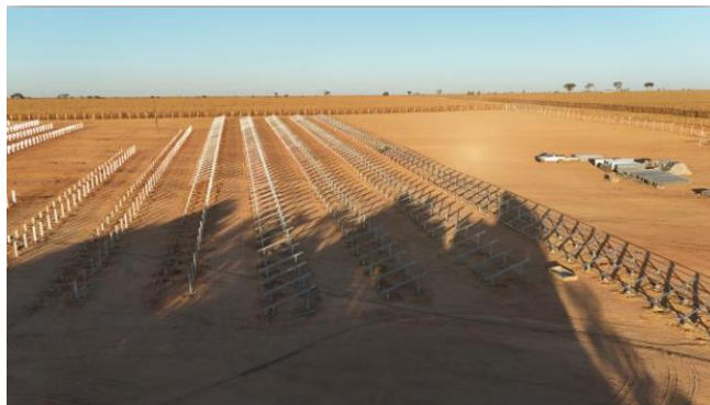
Obras da UFV Liberdade.
