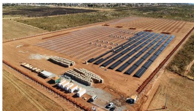
Obras da UFV Mundo Melhor.
