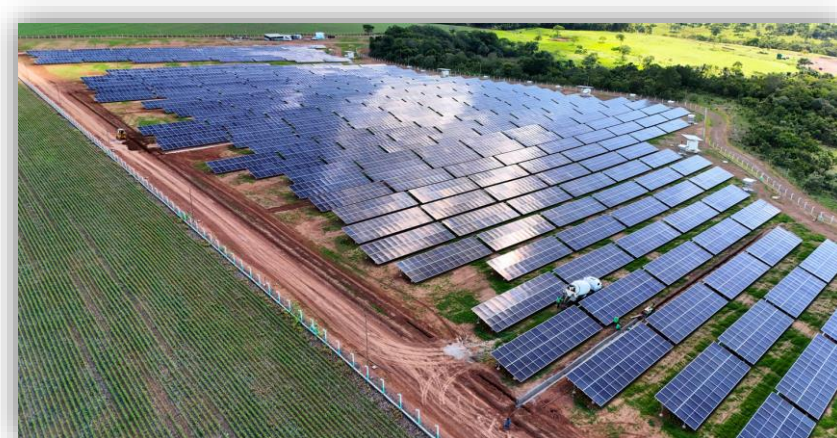
Obras da Ufv Liberdade.
