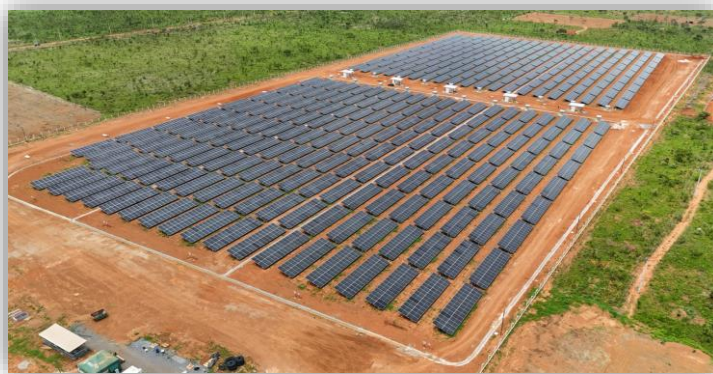
Obras da UFV Mundo Melhor.
