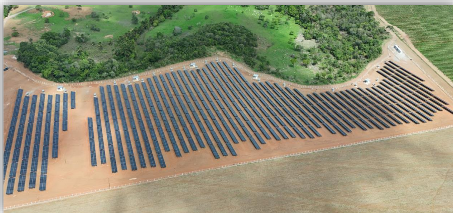
Obras da UFV Liberdade.
