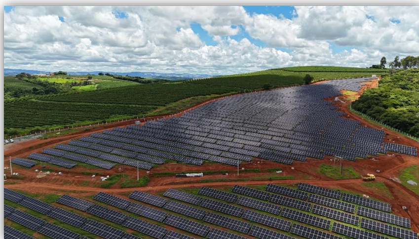
Obras UFV São Bento Abade.
