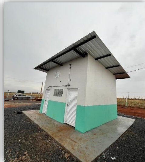
Sala de O&M
